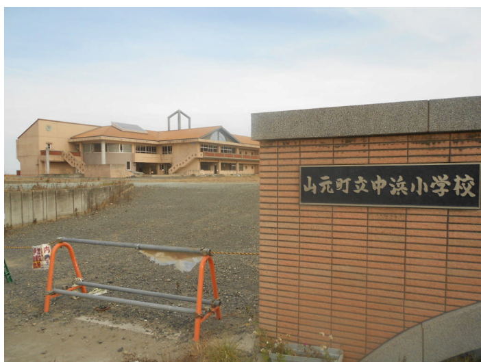
元山元町立中浜小学校です。学校建設時に1mかさ上げのところ、建設業者の計らいで2mかさ上げしたことが児童や先生の全員の命を救ったのだと話されていました。
