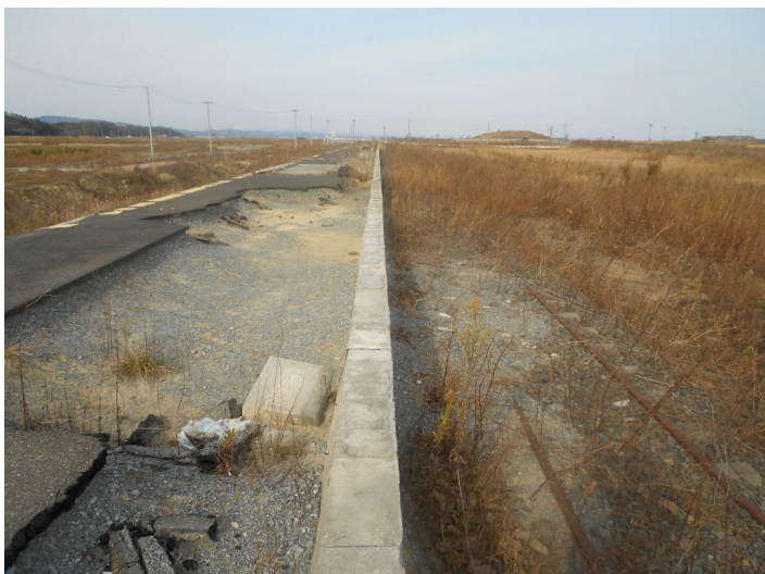
JR常磐線の坂元駅のホームがあったところです。この線路は廃止して山側に新たに敷設されることでした。
