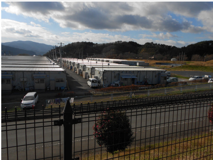
阪神・淡路大震災の設計で建てられた仮設住宅は、東北の寒さでは厳しい生活環境とのことでした。
