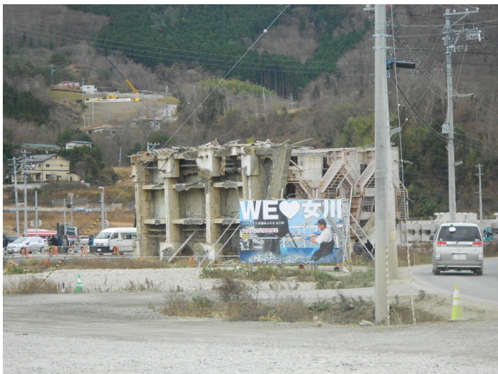
女川町の中心部にあり、被災のシンボリックな横倒しの建物も再開発のため取り壊しが決定したそうです。
