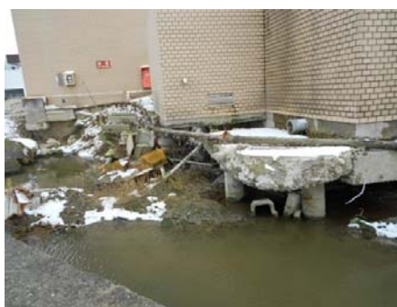
宮城県気仙沼合同庁舎跡で、液状化現象で建物が浮いた状態でした。
