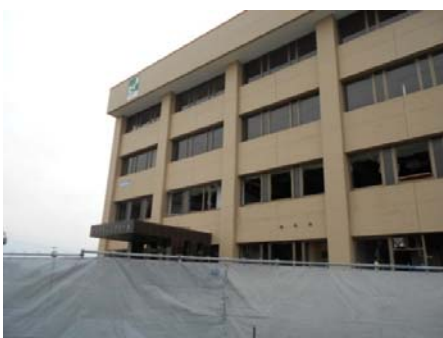
宮城県気仙沼合同庁舎跡で、液状化現象で建物が浮いた状態でした。
